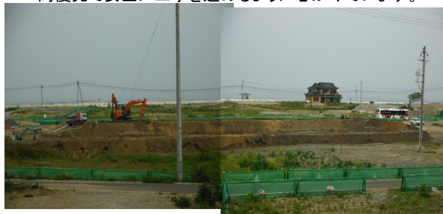
仮調整池の築造
