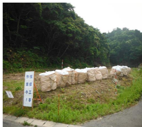
伐採作業を終えたところ
