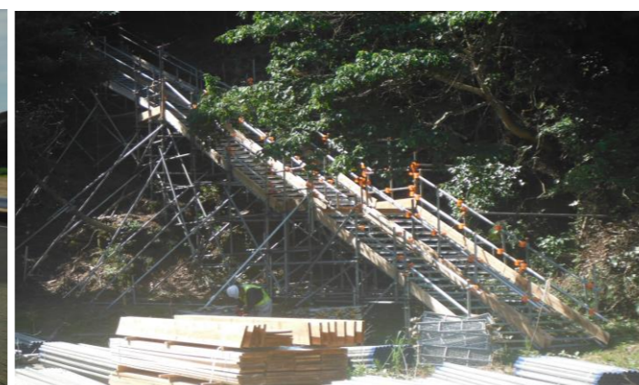
代替避難路設置工
