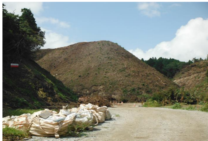
奥まで伐採の進んだ高台工事入り口付近
