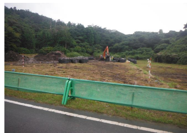
北側仮設調整池のための大型土のう作成
