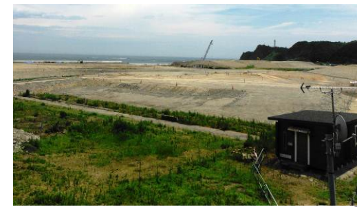
平場の造成状況
