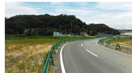
平場の造成状況
