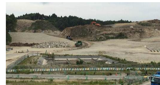
高台の造成状況
